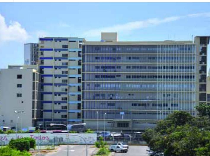
La estructura actual consta de varios módulos de 4 y 9 pisos construidos todos en concreto armado. La fachada principal utiliza parasoles verticales para atenuar la incidencia de los rayos solares sobre el edificio. Es una muestra de la llegada de la modernidad arquitectónica a la ciudad de Maracaibo. Tiene área de estacionamiento y zonas arborizadas. Se encuentra en regular estado de conservación.
