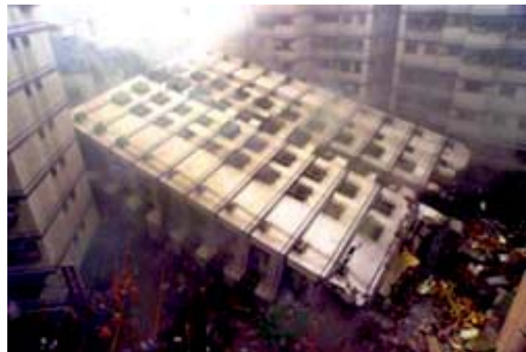
Efecto de licuación como consecuencia del terremoto Kobe en Japón (1995) Escala 7.2 Richter. Tomada de:
