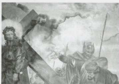
Manchas de humedad oxidadas en Estación N o V del Vía Crucis de San Isidro.
