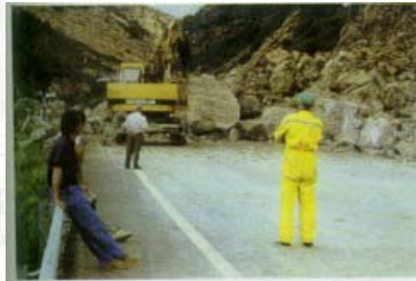
Fig. 18. Corte de una carretera por desprendimiento.
