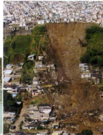
Figura 14. Deslizamiento producido en la ladera de un cerro en la ciudad de Teziutlán (México).
