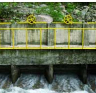
Es una edificación rectangular, que tiene un dique de 6 puertas con entradas de agua desde el río, un tanque principal con 4 compuertas para la captación de agua, utilizando como medio el dique de concreto armado, para despachar un aproximado de 2.500 litros por segundo en tiempo de invierno y
