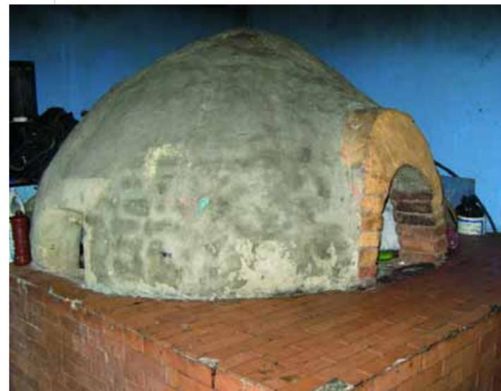
El horno está construido de ladrillos de adobe y unido con morteros de tierra y arcilla, es de 2 metros de ancho por 1,5 metros de alto, en su bóveda caben 5 bandejas de hornear. Tiene dos bocas de respiradero, una perteneciente al mismo horno y la otra para desechar las cenizas que se encuentran ubicadas en la cima del horno en una especie de cúpula.
