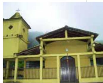
aguas o de cañón con pendulaje de madera cuadrada y encañe de caña y cañuto. Posee una puerta metálica. Su frente ha sido remodelado, incorporando una cornisa adornada de tejas y además varias jardineras. Internamente es de tres naves, posee dos hileras de columnas rectangulares paralelas que las definen. Existen relatos que aseguran que fue construida allí por promesa de un grupo de vecinos para poder hacer el puente sobre el río.
