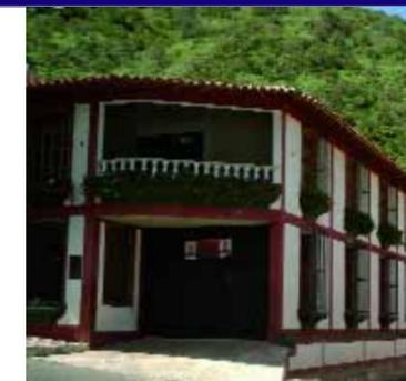
Se trata de una edificación esquinera de construcción tradicional, erigida en paredes de bloques recubiertas con friso de cemento de acabado liso y pintura. Es una estructura de un piso de altura. Las puertas de acceso a la edificación son de madera enmarcadas en vanos sencillos de madera. Cuenta con techo de estructura de madera cubierto de tejas de barro cocido.
