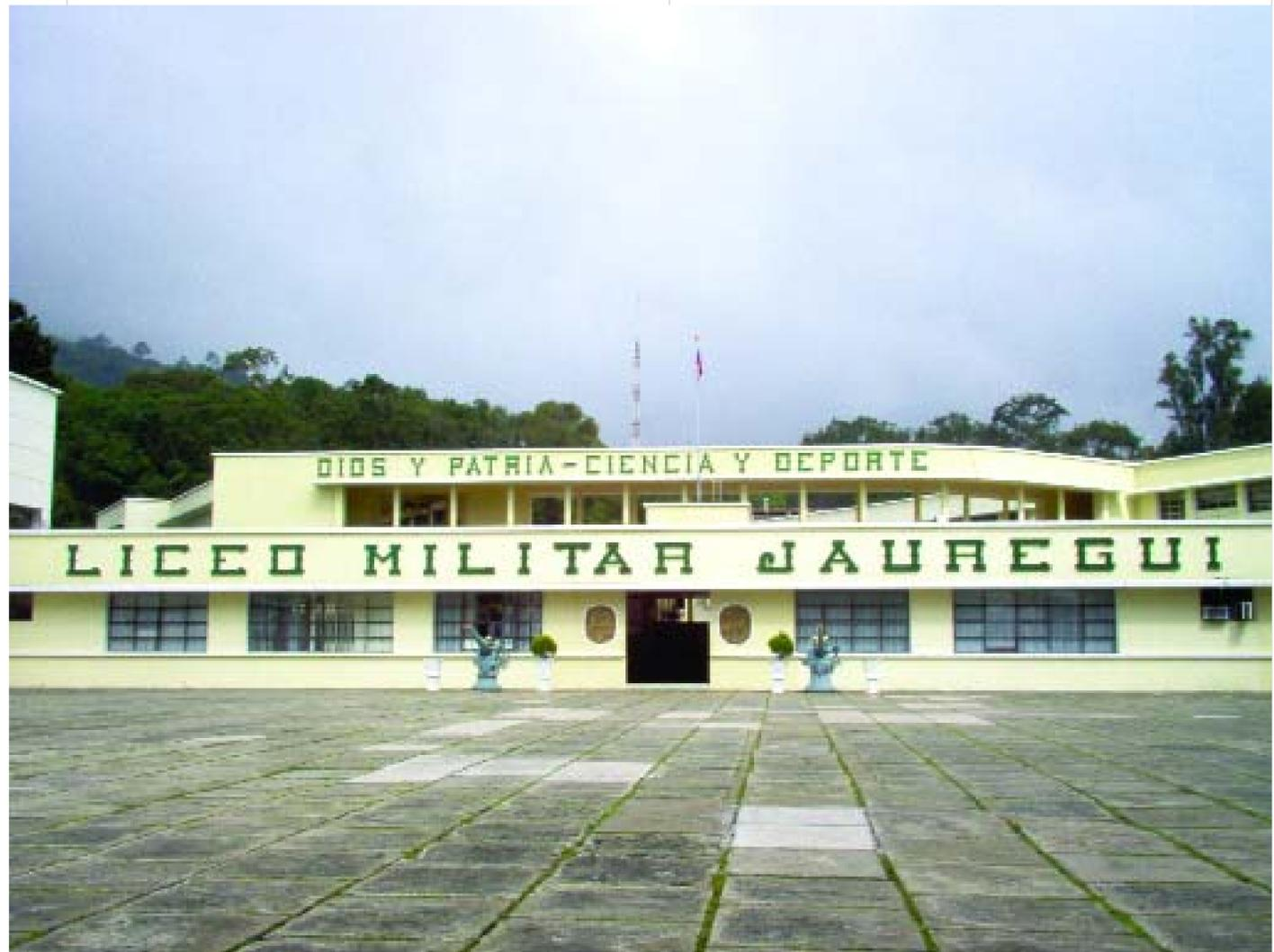
edificios correspondientes a las aulas, la administración y el teatro. El conjunto posee una cubierta plana en concreto armado y vaciado en sitio, con entresijos del mismo material, y sus muros están hechos en mampostería de bloque de arcilla y estructura en pórticos de concreto armado. Las puertas son de madera a dos hojas.
