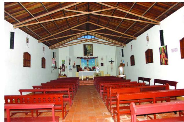
Construida en 1976, esta edificación presenta una nave principal, compuesta en la parte posterior por un torre que funciona como campanario. Posee tres portones de acceso hechas en madera. Para su construcción se utilizaron materiales tales como paredes de bloque de cemento, techo a dos aguas de cemento cubierto con tejas criollas y machihembrado. En su fachada principal cuenta con una marquesina de acceso a la capilla. Tiene ventanas con formas apuntaladas alrededor de ella en madera. Fue
