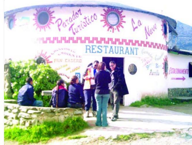
Esta edificación llamada La Nave es una construcción hecha con un sistema tradicional, paredes de bloque con friso liso y ventanas en forma circular fabricadas con hierro y vidrio. La estructura formal de esta edificación guarda una similitud con la idea que se asocia con un platillo volador.
