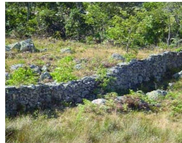
Los campesinos del municipio acostumbran a construir estas estructuras que se forman encajando una serie de piedras de distintos tamaños, unas sobre otras, hasta formar pequeños muros de 1,50 m de altura aproximadamente. Se emplean para demarcar límites de terrenos entre las fincas o realizar corrales de animales. Este tipo de construcciones eran muy usadas por los indígenas quienes las hacían para protegerse.
