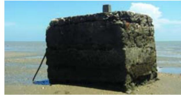
Este surtidor fue construido en concreto a finales del siglo XIX. Su estructura consiste en un tanque hermético, de 4 m de largo por 4 m de ancho, de forma cúbica. Este tanque servía para almacenar el combustible traído por los barcos, que llegaban al puerto de Irapa, para luego ser distribuidos y comercializados a los habitantes de las diferentes comunidades. El combustible era trasladado en barriles de madera, utilizando como medio de transporte burros. Presenta mal estado de conservación.
