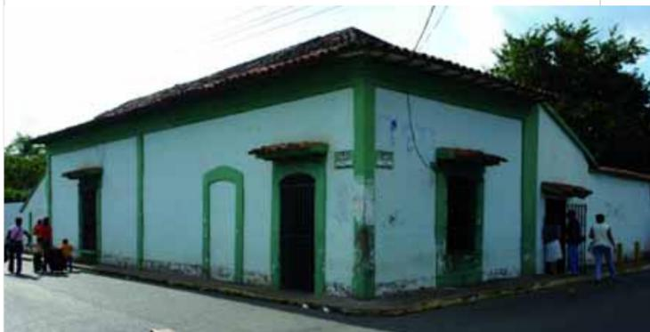
borde de una planta con altas ventanas y techo a dos aguas que conserva los materiales originales como la madera para estructura y entablado, y las tejas criollas. Se encuentra en regular estado de conservación.
