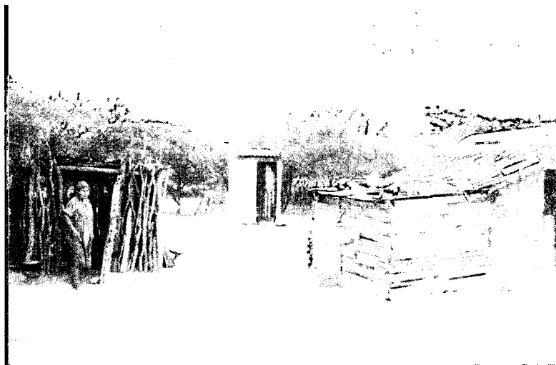
Unidad sanitaria Ranchería Mayapo
