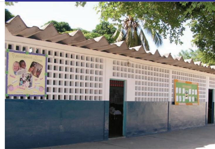
los niños, así como áreas verdes. La estructura de la escuela es de concreto, paredes de bloque, puertas y ventanas metálicas, techos de asbesto y otros de placa de concreto.
