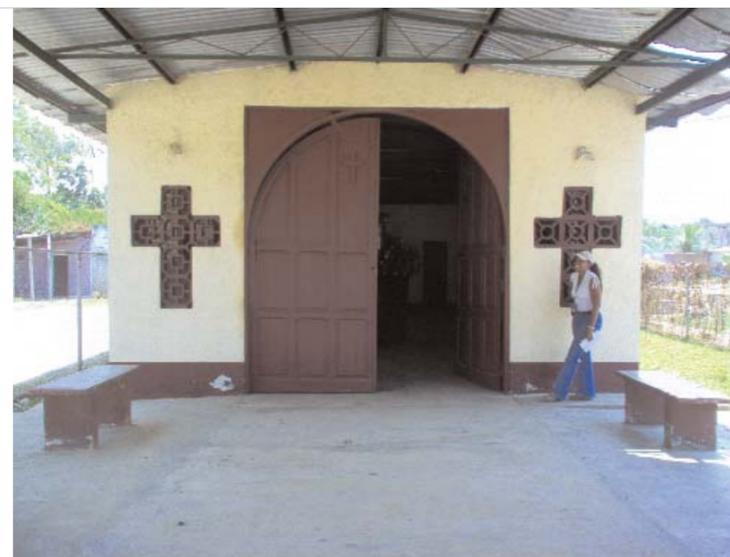
ber, estructura de concreto armado y hierro, paredes de bloques frisados, pisos de cemento, puertas y ventanas de metal, techos de láminas metálicas sobre estructura de hierro a dos aguas. La fachada principal muestra un muro con gran vano de acceso rectangular al centro y frontón triangular. Es un bien muy significativo para la comunidad católica del lugar.
