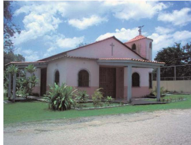
Es una sencilla edificación de uso religioso que se implanta en una parcela aislada circundada por aceras perimetrales y áreas verdes. Fue levantada con estructura de concreto armado, paredes de bloques frisados, puertas y ventanas de madera, metal y hierro. El techo es de estructura metálica a dos aguas con láminas de zinc, a excepción de los pasillos cubiertos que anteceden las tres puertas de entrada, que son de tejas a un agua. En la fachada principal destaca el
