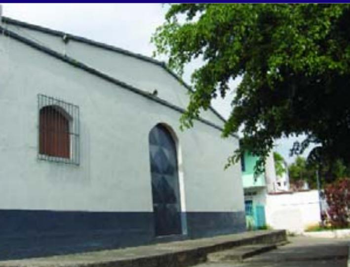
La capilla es una construcción sencilla de doce metros cuadrados, con presencia de ocho columnas de cemento, bloque y vigas, techo a dos aguas de acerolit; la fachada posee una puerta de dos hojas en arco; en una de las paredes laterales tiene una puerta de dos hojas y dos ventanas.
