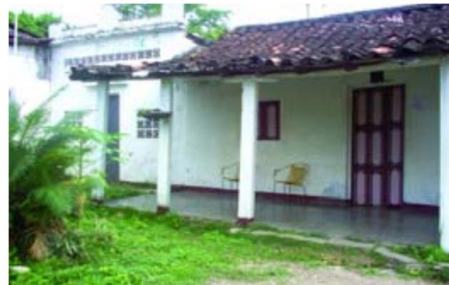
Esta casa en esquina, de una planta, fue construida en bahareque y tierra, con techo a dos aguas con estructura de madera cubierta de zinc y tejas, con alero. En gran parte de esta estructura se conservan las características de construcción tradicional. Posee corredor con tres columnas de madera. En el interior de la misma se encuentra dividida en cinco espacios, el baño se encuentra fuera de la casa. Su fachada es sencilla presentando una ventana de madera y una puerta del mismo material.
