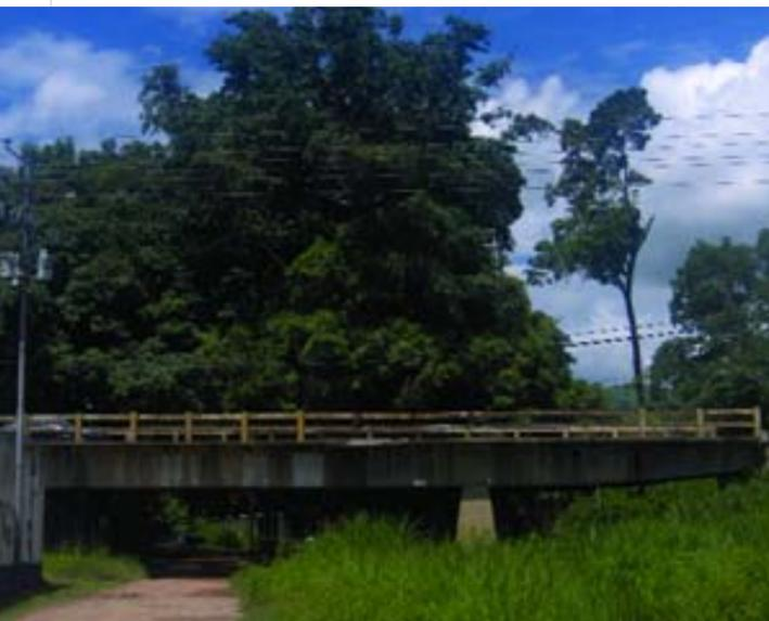
Es un puente de aproximadamente 300 m de largo, por 10 m de ancho; elaborado en concreto armado y hierro.
