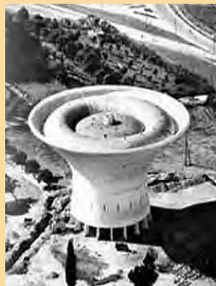
El castillo de agua en Fedala (Marruecos), diseñado por Torroja, tiene la forma de un hiperboloide de una hoja, el cual puede ser precomprimido a lo largo de sus dos conjuntos de rectas generatrices. Esto asegura un concreto sin fisuras.
