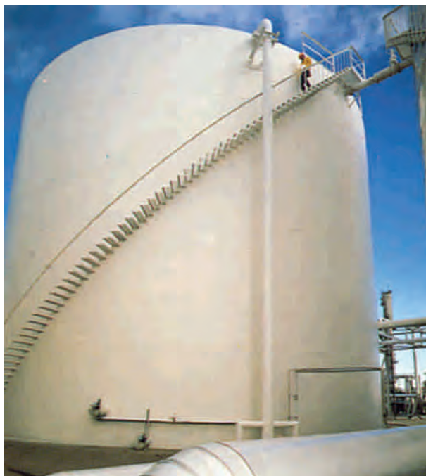
Una escalera siguiendo un arco de loxodroma en la superficie de un tanque cilíndrico. Aquí ese arco de curva forma ángulo constante con cada generatriz de la superficie cilíndrica.
