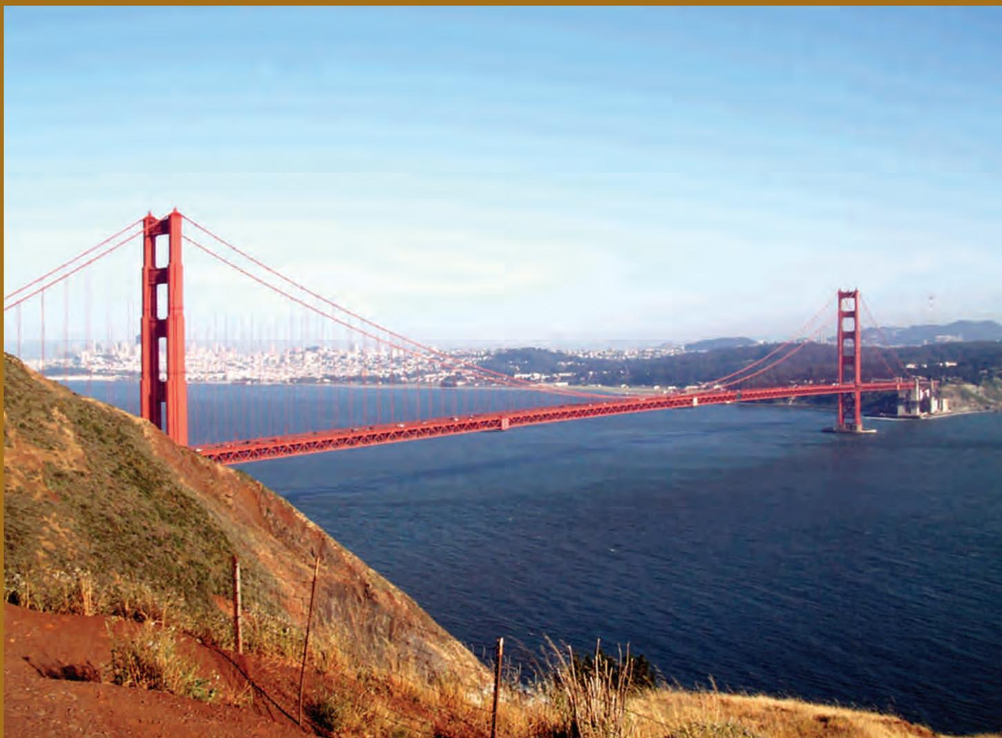
Una aplicación importante de una cónica (parábola) es en la construcción de puentes colgantes. Un cable de suspensión colgado entre dos postes sostiene una estructura de densidad uniforme mucho más pesada que el propio cable y toma la forma aproximada de una parábola. Esto se debe a que la forma parabólica permite sostener un peso uniforme horizontal de tal forma que exista una tensión uniforme en cada uno de los puntos.
