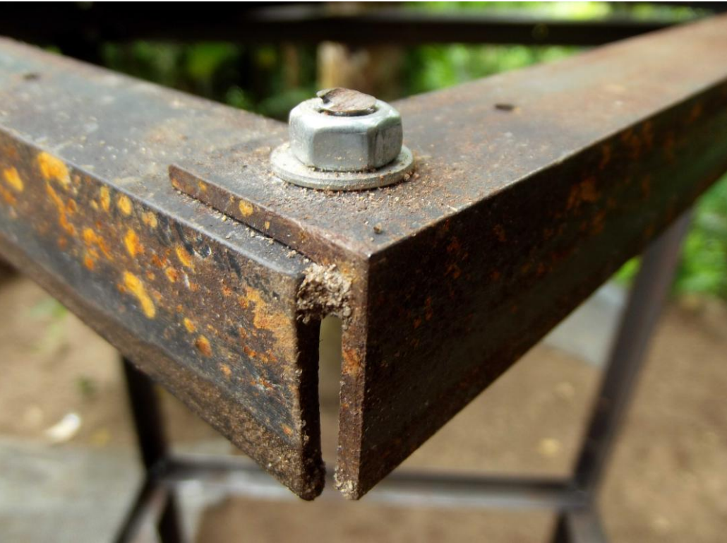
Ángulos metálicos antes y después de retirar el óxido con lijas para poder pintar el metal.
