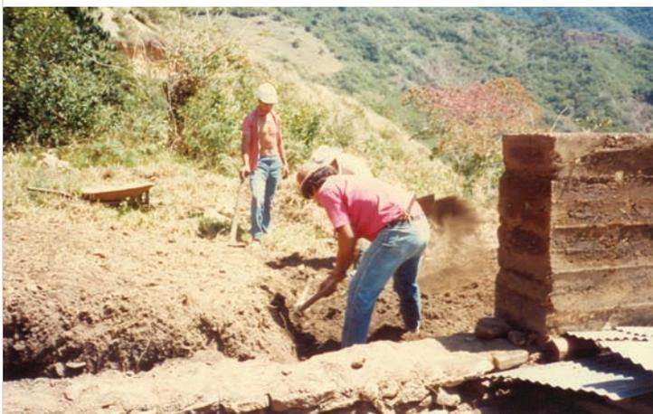
Luego la tierra se pisa con pilones de madera, teniendo en cuenta que cada vacío quede de diez centímetros, posteriormente se elabora un amarre completo y se da el remate en las orillas. Se trabajan las paredes con laja de piedra; y en los umbrales de las puertas y ventanas se colo-
