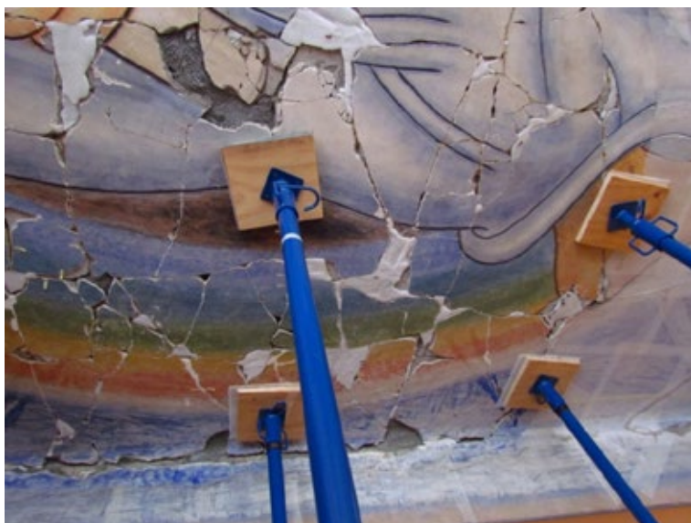
Armado de la superficie 1
