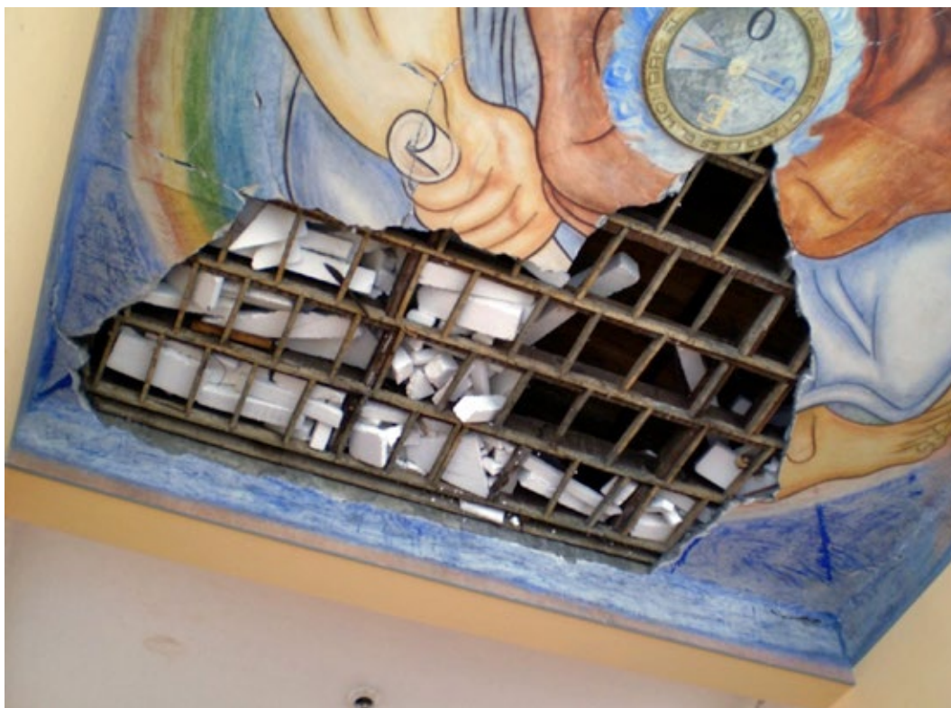
Antes de la intervención 1.
