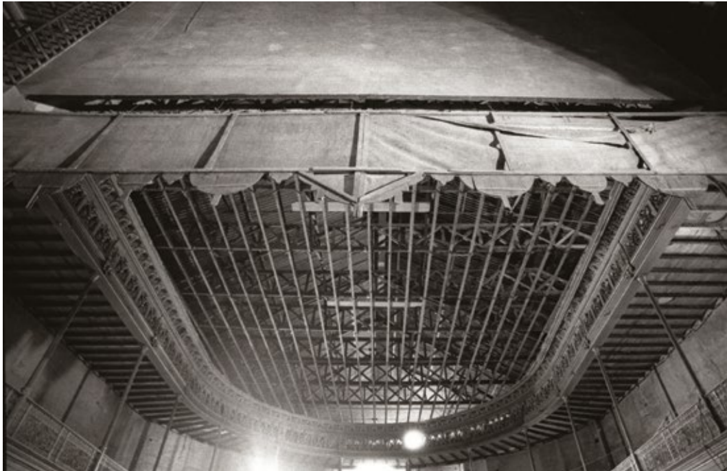
Imagen 13. Teatro Enrique de la Cuadra de Utrera. Imagen durante la rehabilitación.
