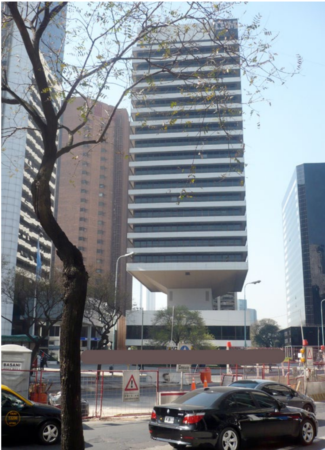
Fig. 2- Edificio de 1980 en Buenos Aires: la línea marca la ubicación material del patrimonio a recuperar.
