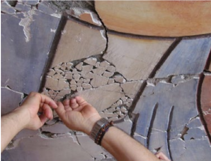
Armado de la superficie
