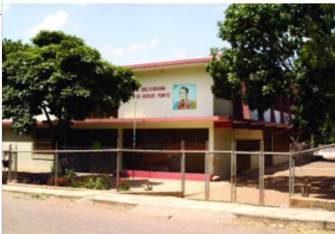
Construida hacia finales de la década de 1950, de estilo moderno, abarca un área de 8.000 m<sup>2</sup> y está formada por un cuerpo continuo de dos niveles al que se le añade el núcleo de circulación. Está construida con bloques y concreto; en el
