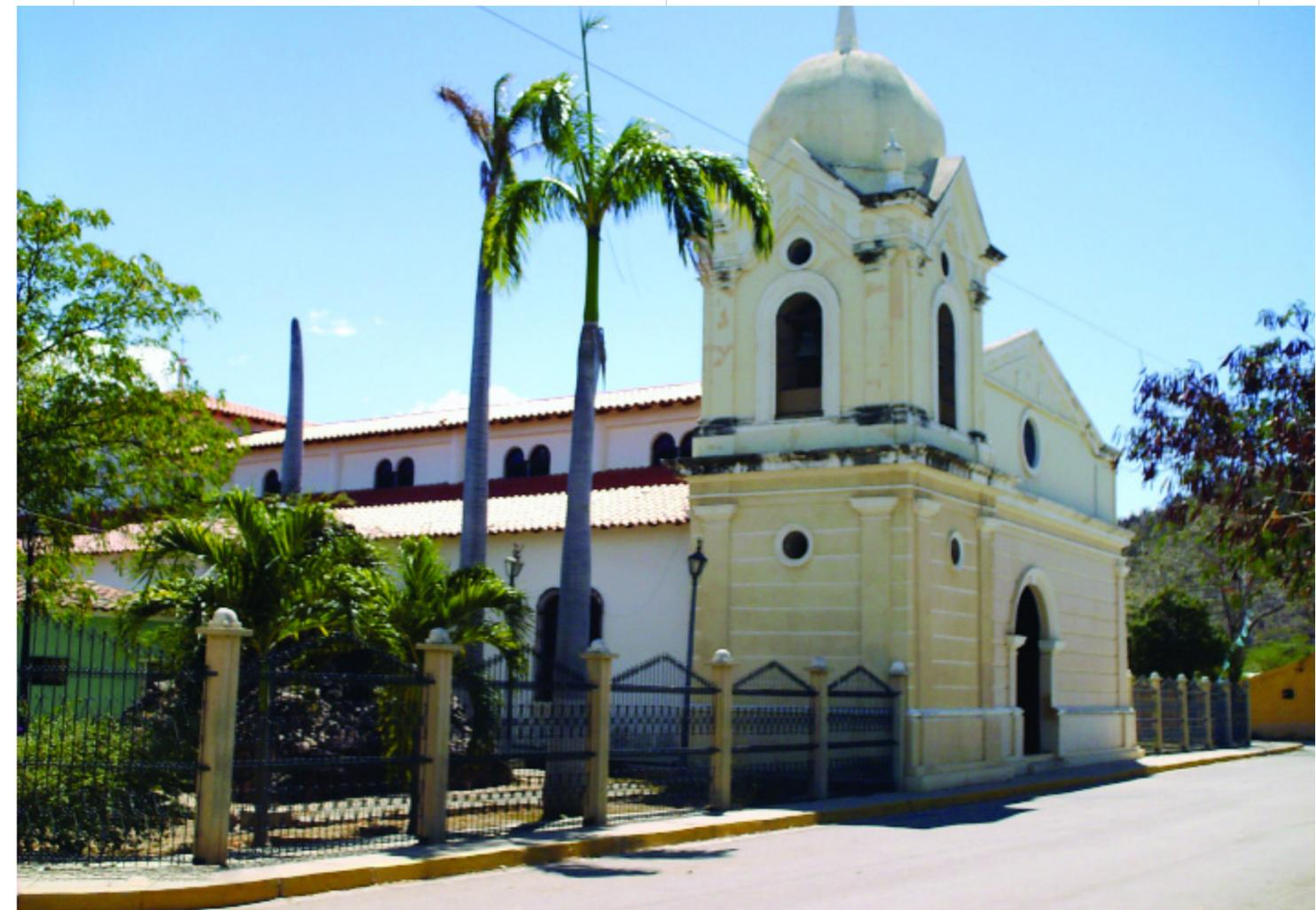
de cebolla con pliegues y remate en pináculo. Por ello se indica que es una estructura recientemente construida con planta basilical a tres naves, columnas cilíndricas y vigas en forma de arco rebajado en concreto armado, techo de viguetas de hierro, machihembrado cubierto de tejas criollas y en su interior piso de granito vaciado.
