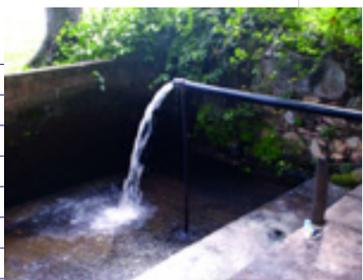
Recipiente fundado en 1922 mediante el levantamiento de una pared de bloques y piedra. Hasta hace algunos años sus paredes eran de zinc, de 5 m de ancho por 6 m de largo y en el interior hay una tubería de hierro que atraviesa el buco y hace las veces de una ducha; allí se encuentra una rueda hidráulica que antiguamente hacía girar unos rodillos que trituraban la caña y de la cual salía un canal con los residuos del cachazo o
