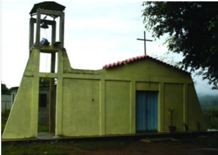
Su construcción data del año 1984. Presenta una disposición en planta de forma rectangular, mide 6 m de ancho por 15 m de largo aproximadamente, de estructura de concreto y paredes de bloque, con techo a dos aguas cubierto
