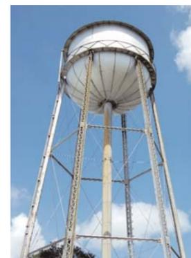
Tanque de metal cilíndrico que se apoya sobre cuatro patas de hierro debajo del cual funcionaban los baños de la estación del tren. Fue construido en el año 1890. De la estructura sólo se modificó el portón. Es uno de los pocos recuerdos que quedan del tren. Presenta mal estado de conservación. La institución responsable de este bien está en la obligación legal
