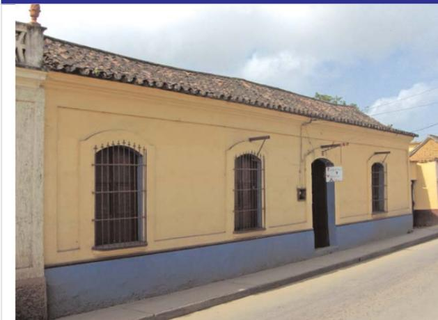
arcos coronando el borde superior con cornisa que soporta el alero del techo. La entrada se da por el zaguán con doble puerta que abren a un patio central con corredor cuyo techo reposa sobre columnas cuadradas. Sus espacios internos giran en torno a un patio central que les permite ventilar e iluminar naturalmente.
