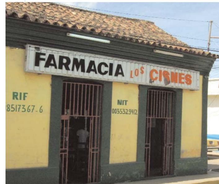
Casa con arquitectura tipo republicana cuya fachada muestra dos puertas con rejas de protección. Fue construida con muros de tierra, puertas y ventanas de madera y techos de tejas que reposan sobre estructura de madera, a dos aguas. La vivienda se desarrolla alrededor de un patio central con columnas cuadradas de ladrillo y zapatas de madera. Actualmente esta edificación es utilizada para fines comerciales, funcionando en ella la farmacia Los Cisnes.
