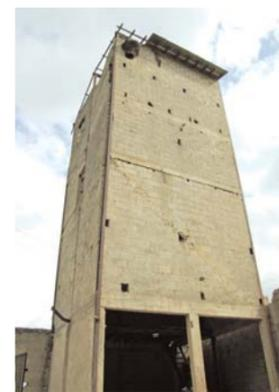
Fue construido en 1952 durante el gobierno de Marcos Pérez Jiménez. Es una estructura de hierro con paredes de bloques levantada en forma de torre con varios tanques subterráneos. Sus paredes tienen más de tres metros de alto, la construcción fue realizada por Dámaso Peña. Anteriormente en el alambique se producía cocuy, alcohol puro y otro llamado anisado. En la actualidad la estructura se encuentra en estado de abandono, oxidado y en la actualidad un grupo
