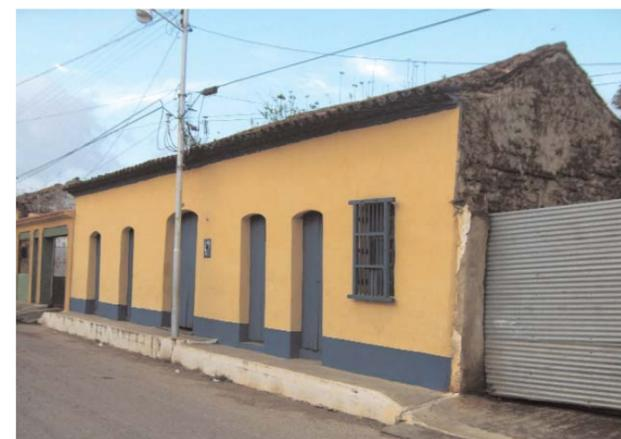
Casa compuesta por dos cuerpos, uno destinado a habitaciones con techo a un agua, el otro con techo a dos aguas donde se encuentra el portón de servicio de uso comercial. La fachada principal muestra molduras y arcos rebajados en torno a sus puertas y ventanas. Fue construida con muros de tierra, techos con estructura de madera y teja criolla de arcilla. Resalta de esta estructura el piso del zaguán de piedra y ladrillos.
