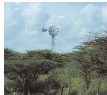
Estructura metálica con base de cemento que sostiene cuatro columnas de hierro sujetadas con paralelos atornillados que aseguran una rueda metálica en la parte superior. Gira impulsada por el viento. Cada vez que la rueda gira crea la extracción de 12 m<sup>2</sup> de agua que llena un tan-
