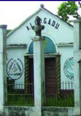
Los salones son consecutivos y cada uno posee techo a dos aguas con láminas de zinc que se apoyan sobre una estructura metálica y muros de tapia. Estos se proyectan hasta el muro de la fachada principal conformando dos frontones triangulares. Debajo de ellos están dos grandes portones de doble hoja metálica, enmarcados por columnas salomónicas. Sobre el dintel del acceso aparece pintada media circunferencia con un sol en su interior.
