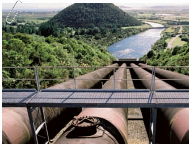
♦ Central hidroeléctrica del Parque Nacional de Tongariro, donde el agua se acopia de las montañas y volcanes.
