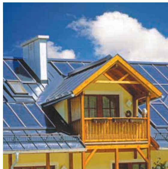
◆ Paneles solares en Viena, Austria.
