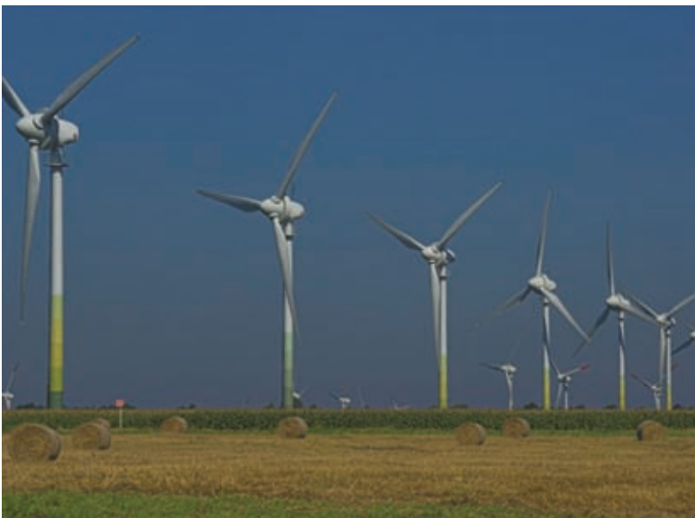
Turbinas de viento en Alemania.
