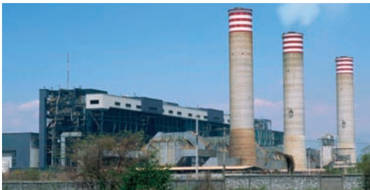
Planta termoeléctrica Plutarco Elías Calles, en Petacalco, Guerrero.
