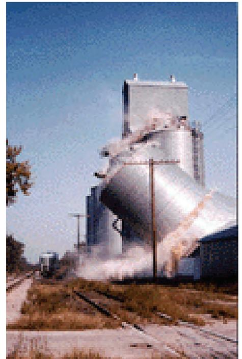
normales: crece con la profundidad. En otras palabras, si el medio granular dentro de un silo estuviera en estado líquido, el silo colapsaría.
