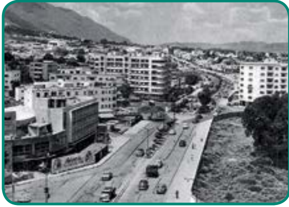
Fig. N° 72 Caracas, Avenida Andrés Bello.
