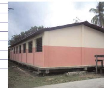
La institución funciona en una construcción tipo galpón con paredes de bloques de concreto frisados y pintados, un techo a dos aguas de láminas metálicas, piso de cemento y una fila de ventana de vidrio a lo largo de las paredes laterales. Está rodeada de áreas verdes y en uno de sus extremos se encuentran arbustos y palmeras. Este centro educativo contribuye con la comunidad en la medida en que le aporta a los niños y jóvenes herramientas para el trabajo productivo.
