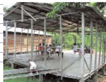
Construcción palafítica con piso de madera que sostiene un techo a dos aguas con láminas metálicas y que no posee paredes en ninguno de sus cuatros lados. En el interior tiene una plataforma de madera de dos niveles que funge de altar y un banco de madera para uso de los feligreses. Allí se congregan los creyentes de esta tendencia religiosa durante las horas de culto, en tal sentido es un espacio de significación cultural para la comunidad.
