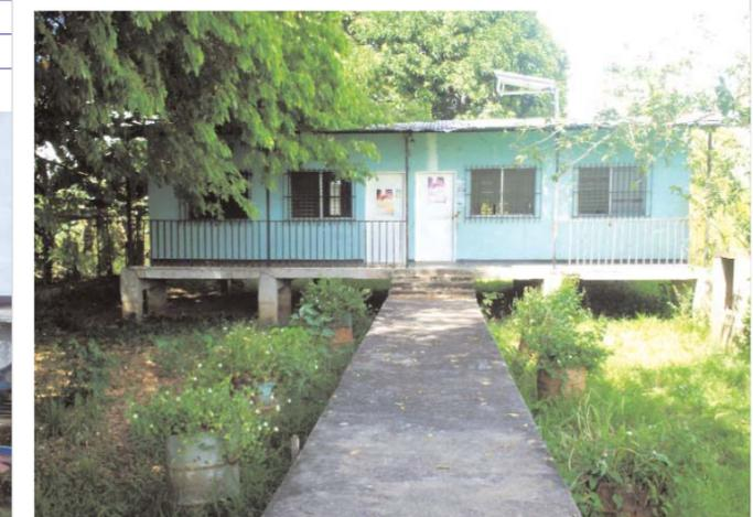
Este centro de atención médica primaria de la población El Toro funciona en una construcción de mayor ancho que largo, a la cual se accede por una larga caminería rodeada de abundante vegetación a sus lados. La construcción es sobre palafitos de madera, techo de láminas metálicas con una puerta central y dos ventanas a cada lado de esta.
