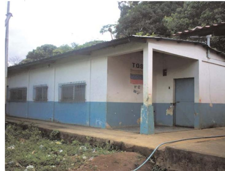
La unidad de servicios médicos primarios de la población de Manoa funciona en una construcción robusta de bloques de concreto frisados, con columnas de concreto armado en su fachada con puerta de acceso lateral. Tiene tres ventanas de vidrio con barras de protección metálicas a lo largo de sus lados; el piso es de cemento y el techo a dos aguas con láminas de zinc.
