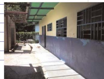
Construcción moderna, con paredes de bloques de concreto frisados y pintados, que tiene los salones de clase con amplias ventanas de vidrio que dan hacia un patio interno de cemento, destechado. El techo de la construcción es de láminas metálicas sobre vigas de acero.
