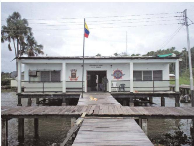
Construcción civil de uso militar tipo palafítica de líneas rectas, techo plano, con una caminería de acceso de madera y que en su fachada tiene cuatro columnas circulares que sostienen al techo, una puerta de acceso y dos ventanas una a
