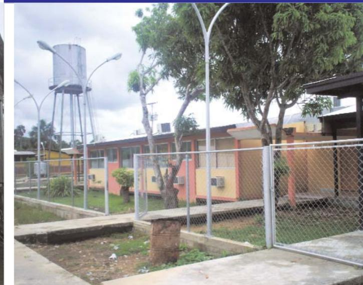
Está constituido por un conjunto de módulos, construidos con bloques y techos de láminas metálicas sobre estructuras de vigas de acero, cada uno sobre una base de concreto y el piso es de cemento pulido. Están rodeados de zonas verdes conformadas por grama y tiene caminerías de cemento que los comunican entre sí. Todo el conjunto está rodeado por malla metálica tipo ciclón.
