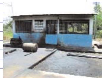
En una construcción de bloques de concreto con puerta metálica, ventilación natural por medio de ventanas de rejillas, techos de láminas metálicas y piso de cemento. Allí se encuentran ubicados los motores diesel acoplados a generadores que suministran la electricidad a la población de Sacupana del Cerro.
