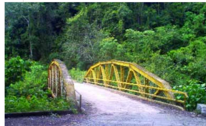
de 2 m por 1 m, soldadas para formar un solo planchón. Se recuerda que esta pieza sustituyó a otro puente colgante de madera por el que sólo podía pasar una persona con su burro de carga a la vez. Ahora transitan vehículos y facilita la comunicación entre los caseríos y poblados cercanos.
