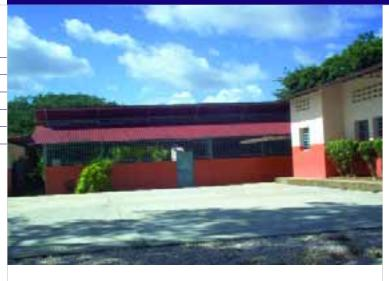
Se trata de una edificación de concreto y bloques, rejas de hierro que se unen con el techo a dos aguas formado por láminas de acero, una superpuesta a la otra. Los salones y oficinas bordean una superficie rectangular de cemento que funciona como área de recreación y esparcimiento.
