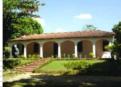
Se trata de una edificación con techo a dos aguas, construido con pares de madera, cubiertos por láminas metálicas y tejas de arcilla. En su fachada principal se observa un corredor externo cuya cubierta está soportada por una sucesión de arcos de medio punto, sostenidos por columnas lisas, procedido por una escalinata con poca pendiente, una puerta principal de madera con doble hoja y dos ventanas con cerramiento de madera a sus lados.
