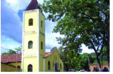
La torre campanario está coronada por un techo a cuatro aguas y supera en altura al cuerpo central de la iglesia. Sus vigas y columnas están construidas en concreto armado, su piso es de granito, las puertas y ventanas de madera, techo con vigas y losas de concreto.
