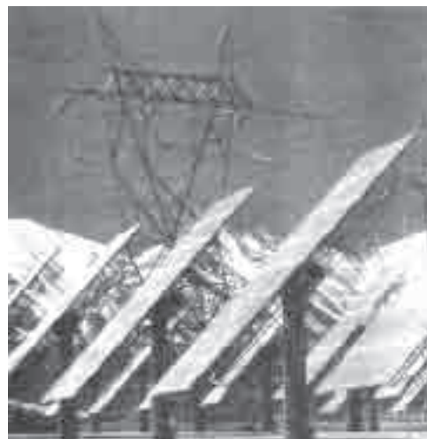
Figura 13. La energía solar puede convertirse en electricidad.
