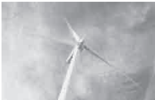
Figura 6. Fotografía de un molino. El viento mueve el molino, éste hace girar una bobina que finalmente genera electricidad. La generación de corriente depende de la intensidad del viento.
