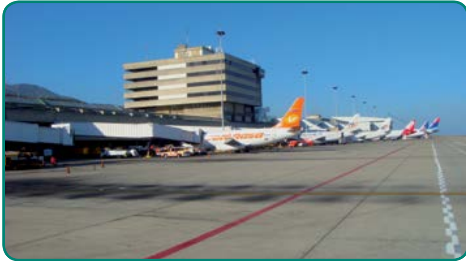
Aeropuerto Internacional Simón Bolívar en Maiquetía, estado Vargas. Fuente: Archivo del MPPE (2012).
