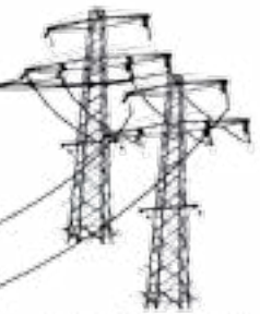
Torre de alta tensión 230 kV
