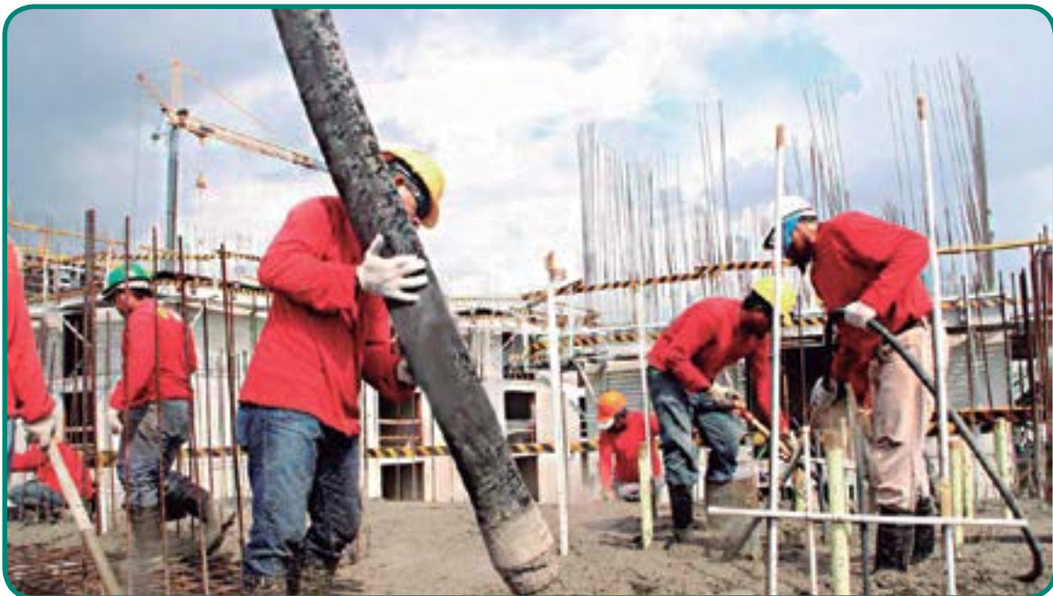
Construcción de viviendas multifamiliares. Fuente: www.albaciudad.org
