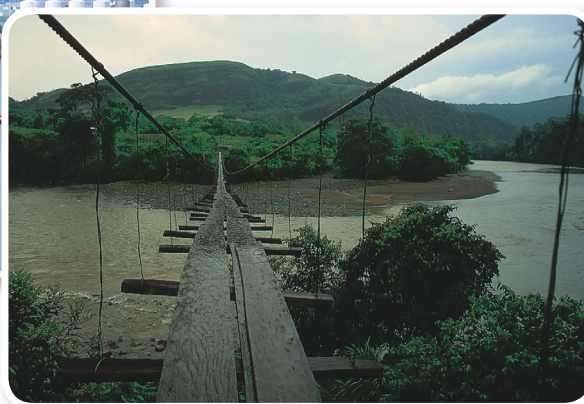
Puente colgante en zona de colonos.
