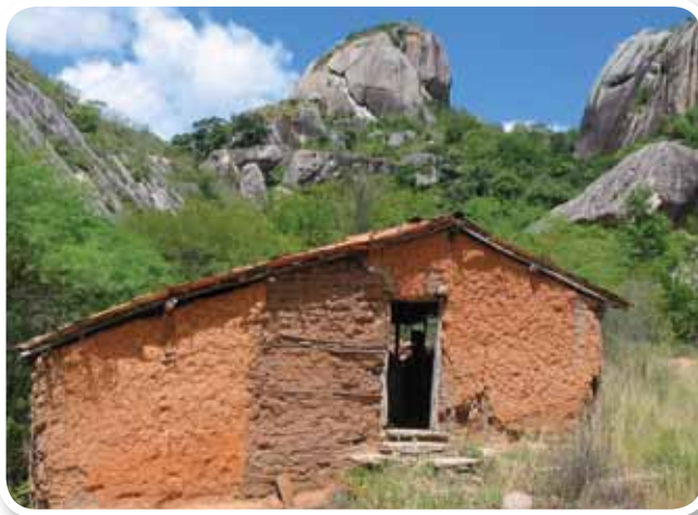
El adobe es una casa de barro moldeada y secada al sol.
