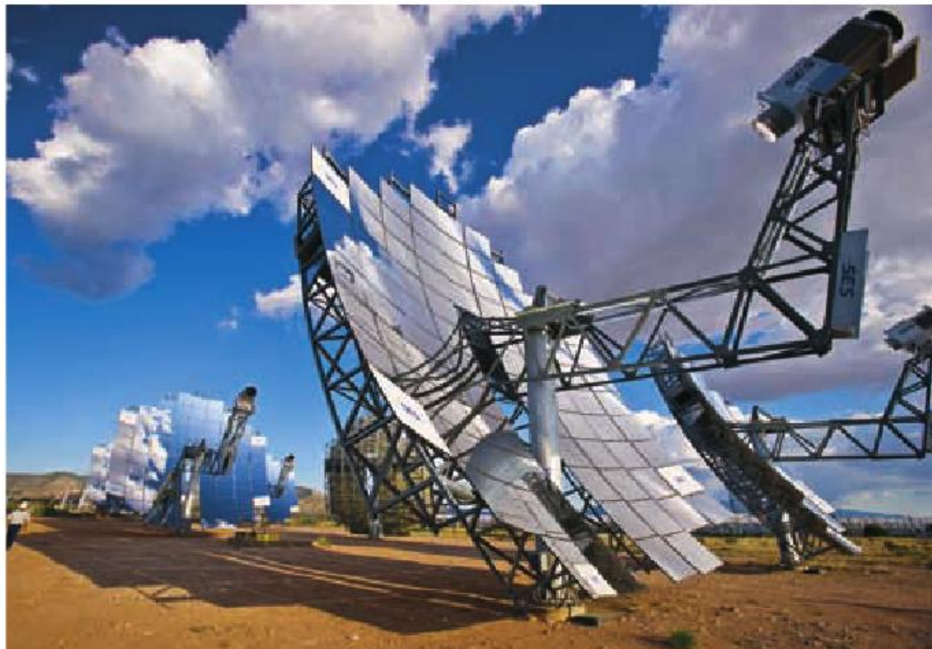
Los espejos concentran la luz solar para generar electricidad. Nuevo México.
