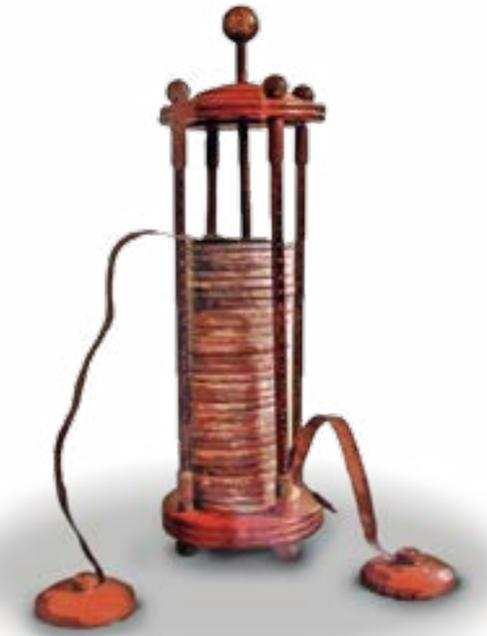
*Figura 3.1. Pila de Volta, producida en 1800, principio de las pilas actuales.*
