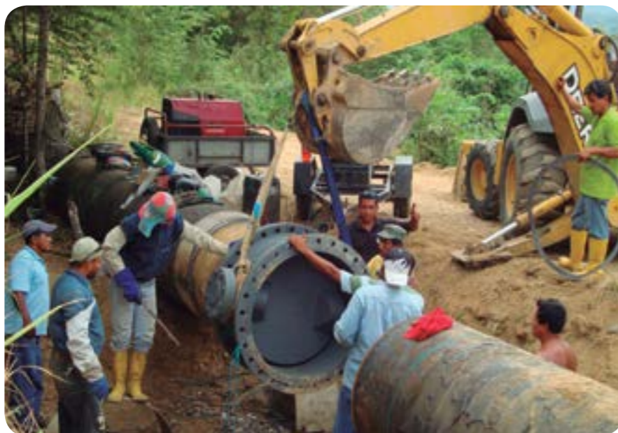
Figura 3.8. Trabajos para la conducción y distribución de agua.
