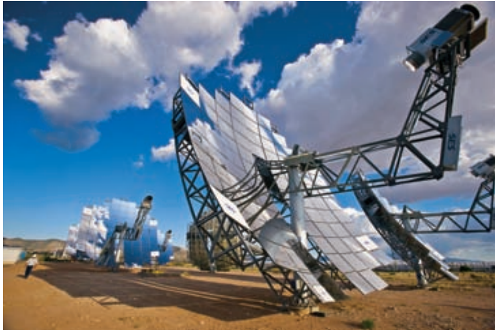
Los espejos concentran la luz solar, para generar electricidad. Nuevo México.
