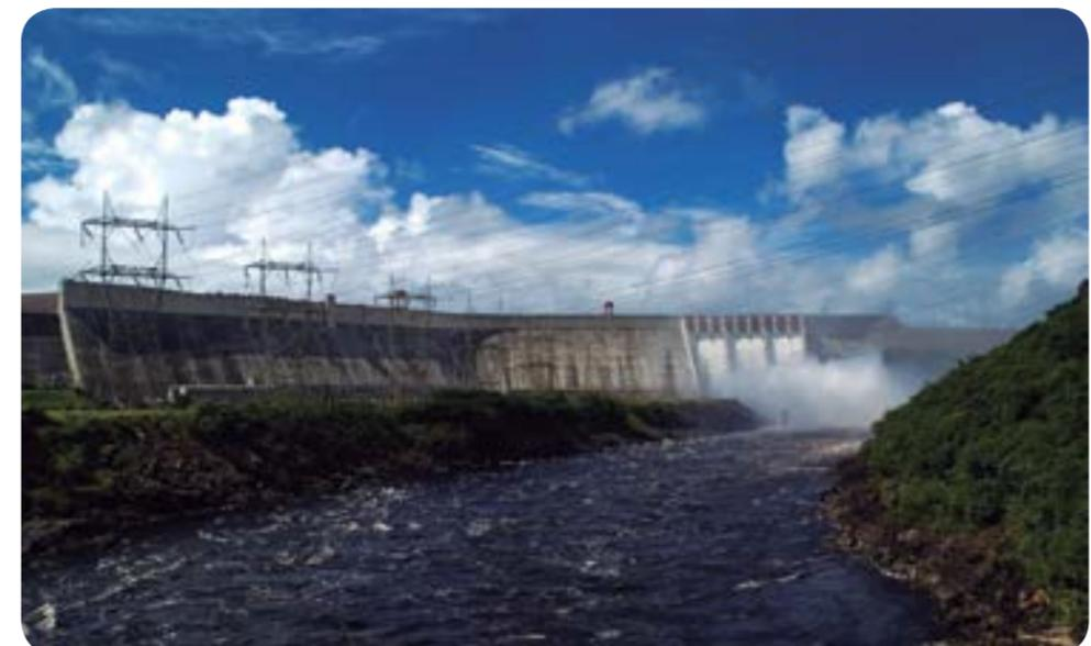
**Figura 11.1** Central hidroeléctrica “Simón Bolívar”. En el embalse, el agua almacenada tiene una energía potencial que se transforma en energía cinética en el agua en movimiento, la cual se aprovecha para mover una turbina conectada a un generador de energía eléctrica.
