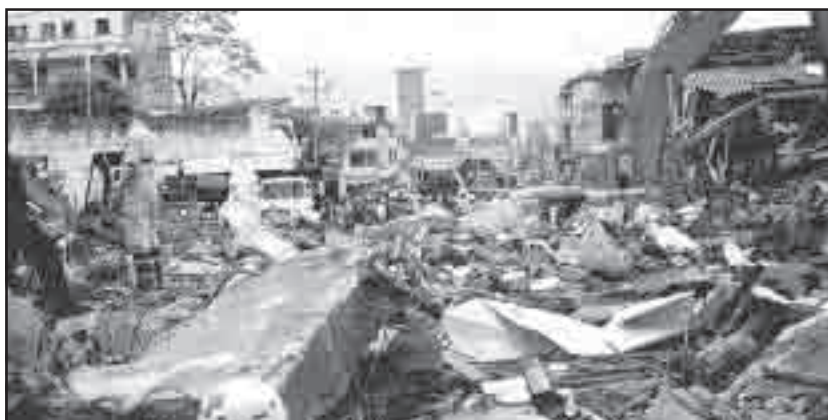
Las tragedias naturales a menudo azotan a nuestro continente, destruyendo la infraestructura construida en años de esfuerzo. Imagen del terremoto de Armenia-Colombia.
