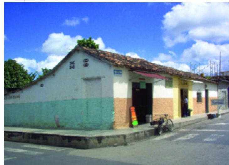
La edificación tiene ochenta años de antigüedad aproximadamente. Se ubica en una esquina del centro poblado y fue levantada con paredes de adobe, cañón —techo a dos aguas con estructura de madera— con tendido de caña amarga y tejas. Su fachada principal muestra dos grandes
