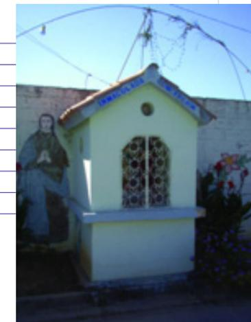
Se trata de una pequeña construcción aislada fabricada con paredes de bloques de cemento frisado, puerta central con arco protegida por rejas que permiten visualizar las imágenes que alberga en su interior, y con techo a dos aguas. Tiene dos niveles y en su interior se encuentra una imagen de la Virgen de la Inmaculada Concepción. Fue construida gracias a los aportes de los vecinos. Es muy valorada por la comunidad devota de la Inmaculada Concepción.
