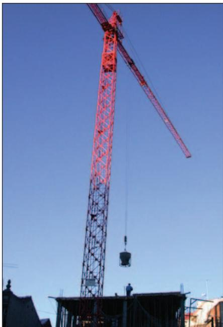
**b)** Una máquina utilizada en la construcción, llamada grúa o montacargas, eleva una caja de 750 kg a una altura de 7,5 m en 15 s.
