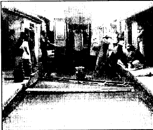
Foto No. 4. Pavimentación de calidad, sin fisuras. Ahorro del 20% en el costo del cemento.
