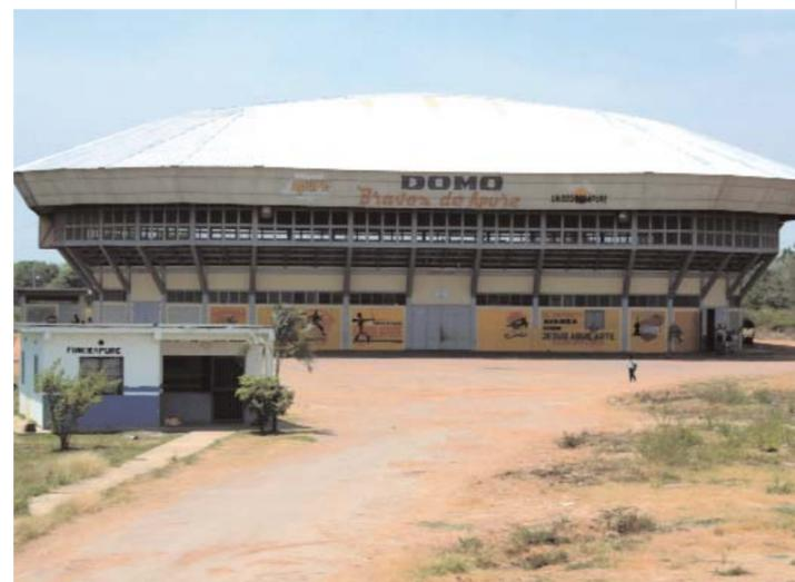
El domo de Biruaca Bravos de Apure es una moderna construcción, de forma elíptica. Posee una superficie de aproximadamente 300 m<sup>2</sup> y una cubierta soportada en estructura metálica en su totalidad. Una entrada principal y dos auxiliares en los laterales definen sus accesos. En su interior cuenta con una cancha de usos múltiples, tablero electrónico, tribunas, baños, cantinas y camerinos. Fue construido entre el año 2000 y 2004.
