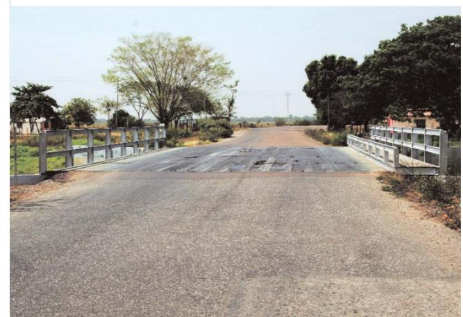
Atraviesa el caño de La Piedra y fue construido en 1969 para conectar al municipio Pedro Camejo con Biruaca. Está edificado con láminas metálicas estriadas y vigas doble T. Se encuentra en mal estado de conservación.
