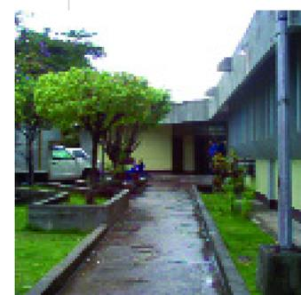
Se ubica en una parcela que ocupa media manzana frente a la plaza Bolívar de Puerto Ayacucho. Es una construcción moderna elaborada a finales del siglo XX con estructura en concreto armado paredes de bloque frisado, puertas y ventanas de madera metal y vidrio y techo de platabanda. Internamente alber-
