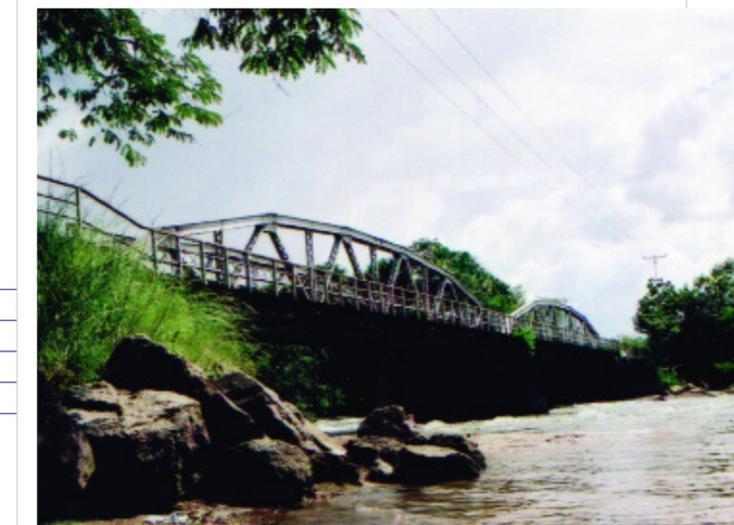
Es un puente de 150 m de largo por 15 m de ancho y 10 de alto con estructura elaborada totalmente en acero que permite el paso vehicular sobre el río Cataniapo. Construido en la década de 1950 al igual que mucha de la infraestructura del
