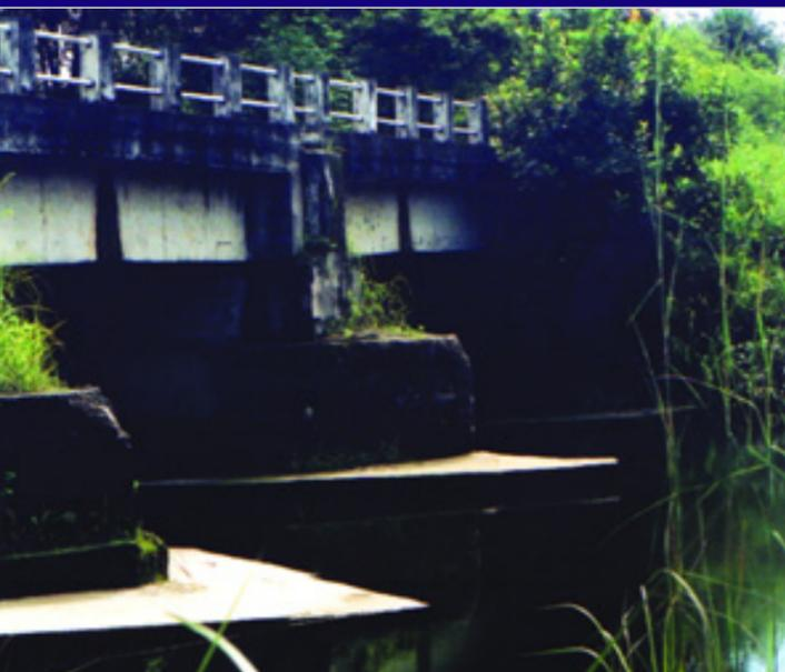
Se trata de una obra vial erigida en la década de 1950 durante la construcción del eje carretero sur de la carretera nacional y es una estructura de concreto, piedra y metal que atraviesa el río Guayabal. Tiene 25 m de largo por 10 m de ancho, posee una acera en uno de sus márgenes y es de doble vía. Comunica por vía terrestre el sur del municipio Atures con la capital del estado Puerto Ayacucho.
