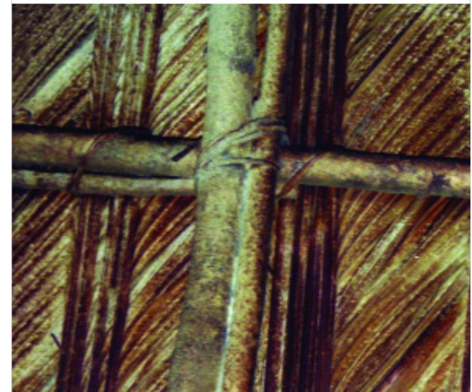
El techado se realiza por un procedimiento de solapado que es una forma de armar la distribución de las hojas ya secas y en la que se intercalan una penca sobre otra de forma horizontal sobre una estructura con bejuco que es el soporte del techo, atando las palmas al bejuco con fibras vegetales o cuerda del monte como se le denomina local-
