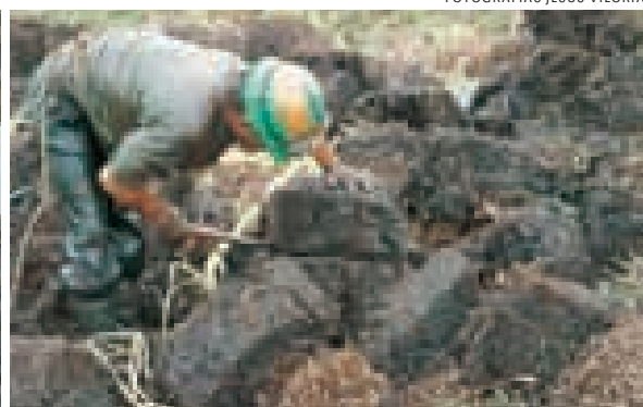
El tamado de la materia orgánica (fibras vegetales) permite la formación de bloques compactos, como estos extraídos de la excavación.
