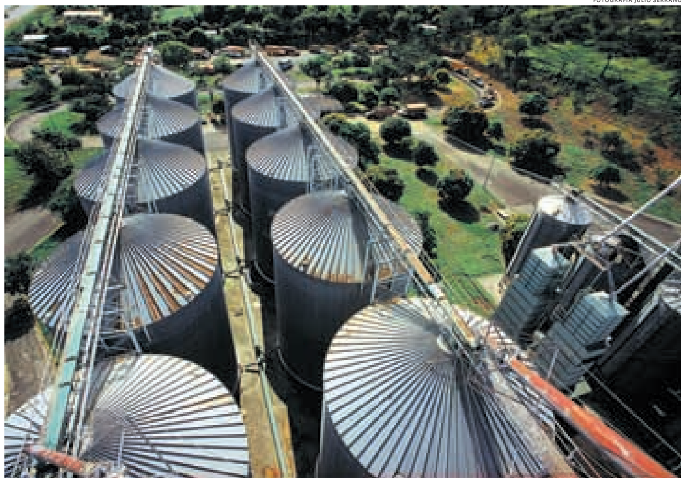
Silos de arroz, estado Barinas.
