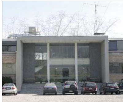
Edificio principal del Observatorio Cerro Calán.
